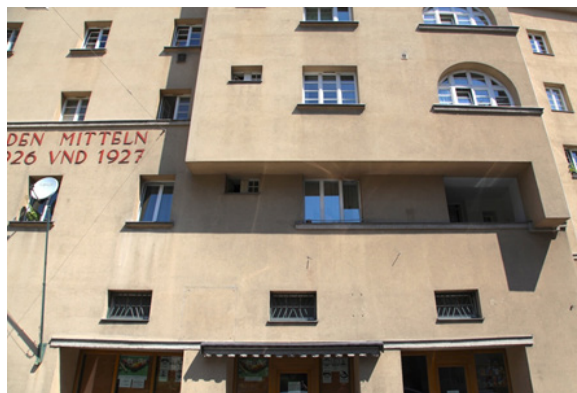
Figura 8 - Projetado pelos arquitetos Heinrich Schmid e Hermann Aichinger, Matteotti Hof contém 452 apartamentos em edifícios interligados agrupados em torno de cinco pátios. A maioria das fachadas apresenta formas variadas de janelas, portas de entrada estilizadas e massas irregulares projetadas para criar interesse visual.
