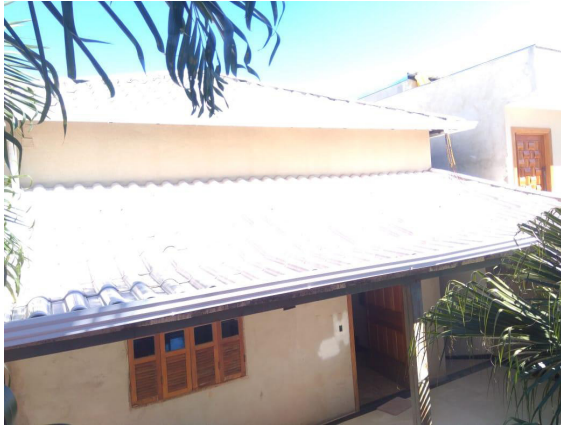
Figura 5 – Telhado frente da casa
