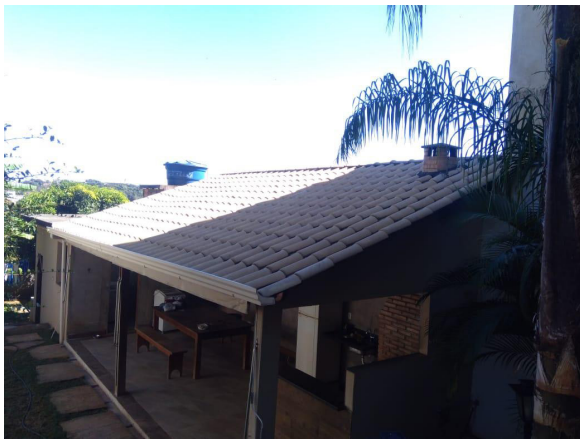
Figura 6 – Telhado área de lazer.
