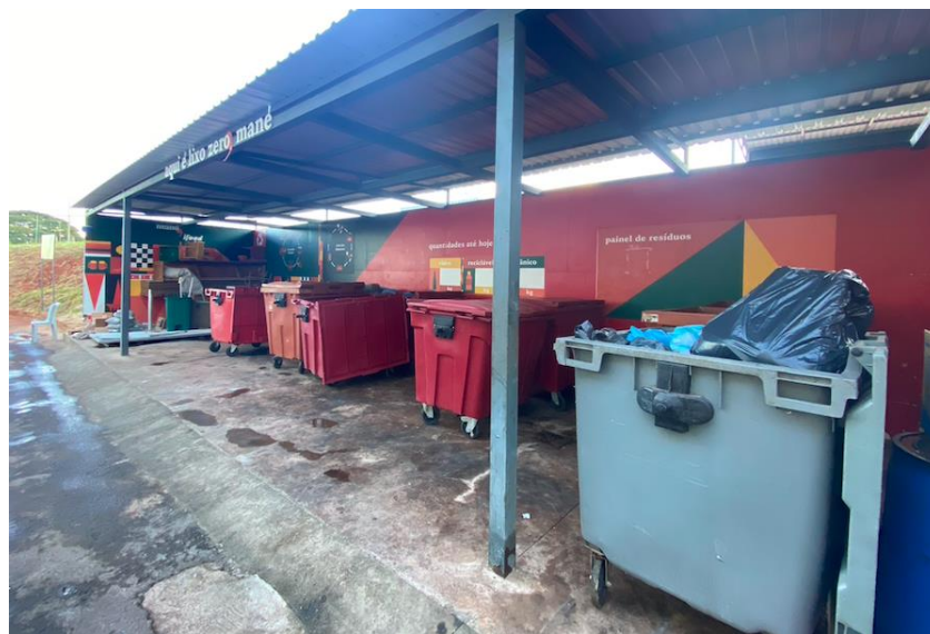
Figura 16 - Disposição dos resíduos em contêineres no abrigo de resíduos do Mané.
