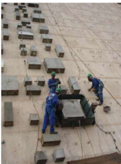
Figura 21: Obra de Recolocação dos Cubos - Fachada Norte - Teatro Nacional
