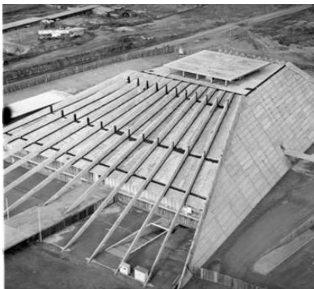
Figura 3: Teatro Nacional em construção
