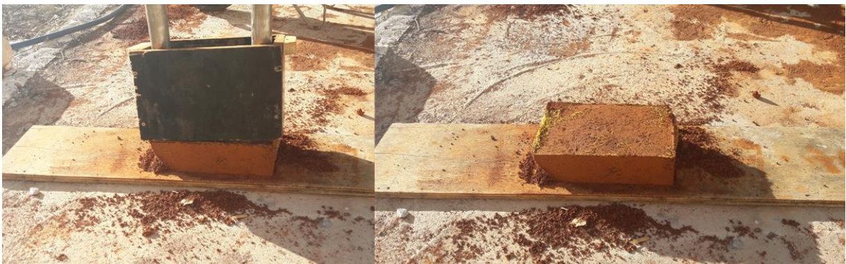
Figura 4 – Retirada da forma.
