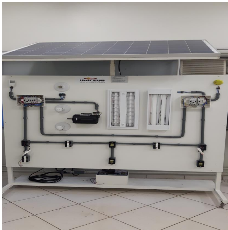
Figura 9 – Painel com a montagem final.
